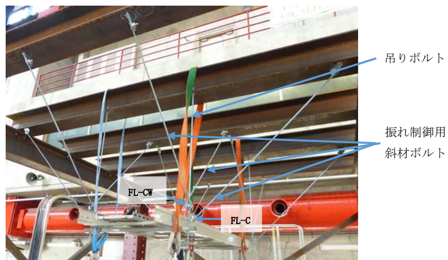
【振れ止め構造概要】
